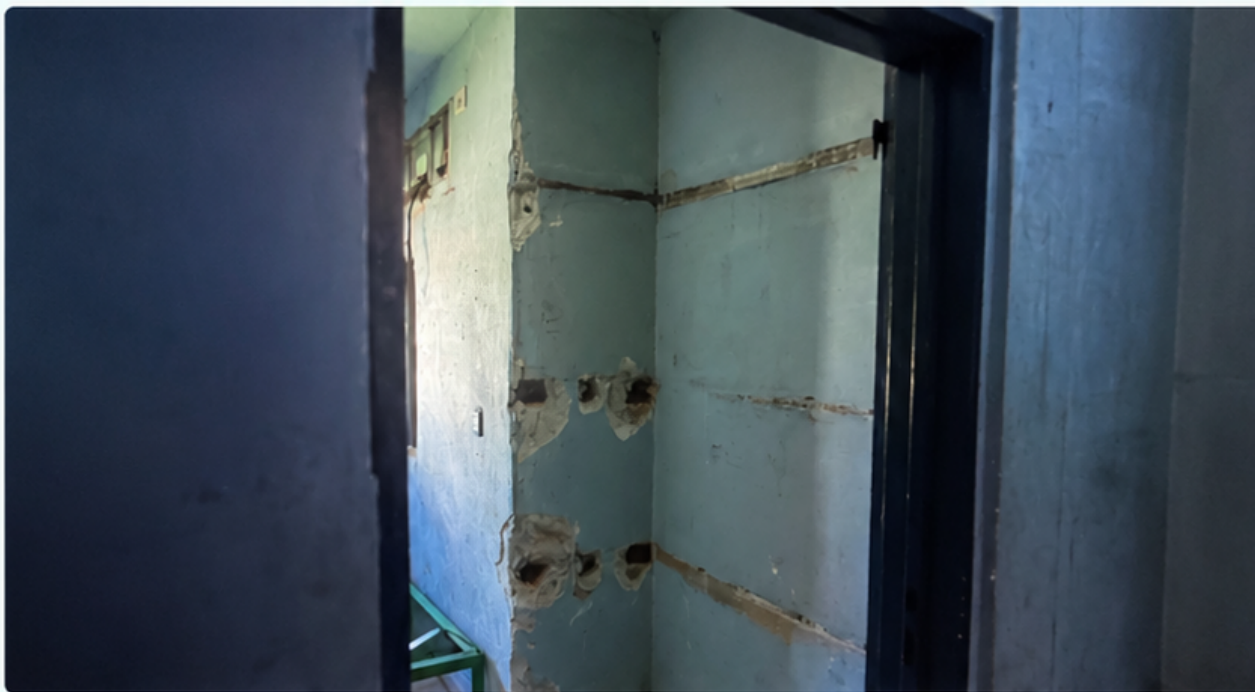
CSE Aldea Tres Horquetas: Falta de mobiliario
