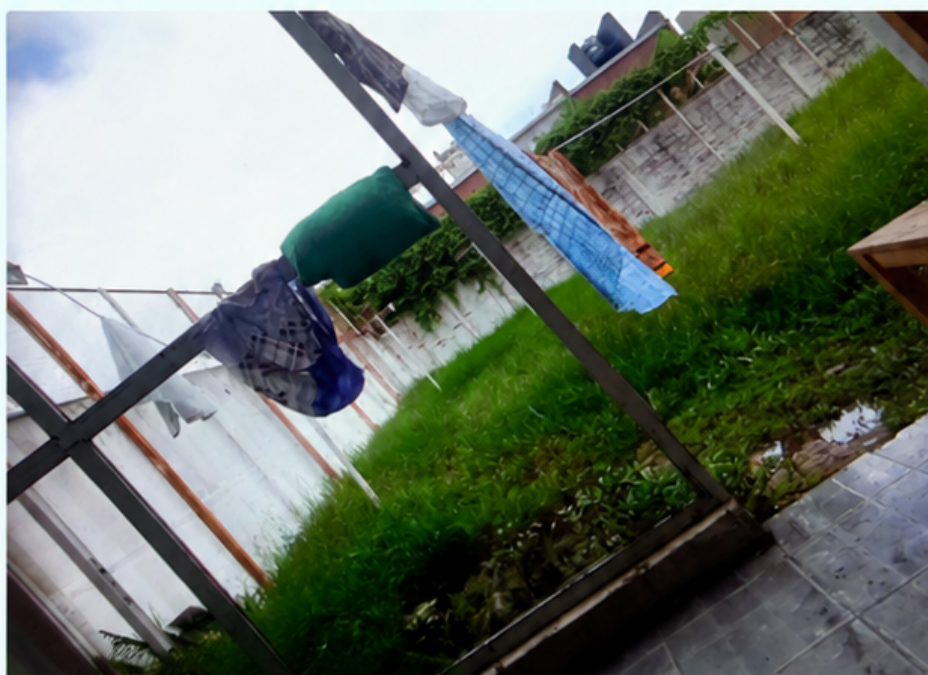
Espacio Alternativo de Contención N° 3: las cloacas que rebalsan están cerca de las habitaciones donde duermen los chicos a la misma altura del piso.
